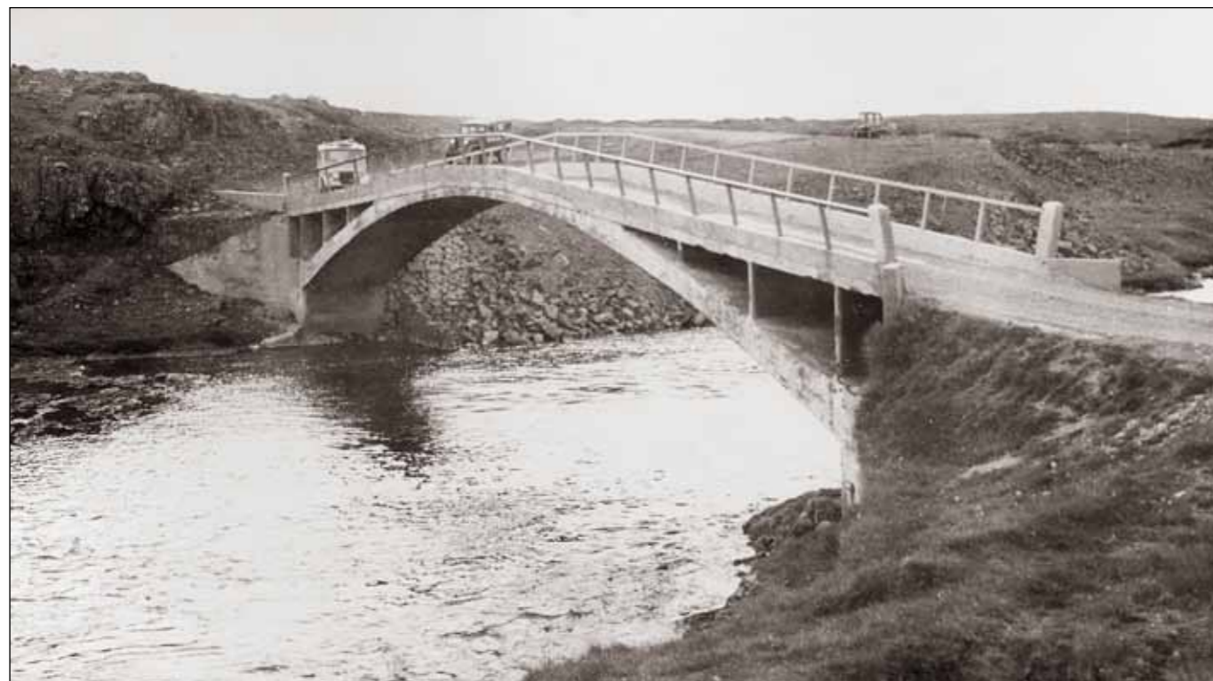
Brúarvinnu menn frá Hvammstanga gera upp gamla brú yfir Haffjarðará á Snæfellsnesi sem notuð verður sem göngubrú. Viðgerðin felst í að steypa ofan á og utan um bogann. Síðan nýir veggir þar á og dekkið endurnýjað. Allar brúkur endurgerðar í upphaflegu formi og nýir endastólpar. Þá kemur alveg nýtt handrið. Einnig verður það framleitt á vegfyllingum við brúarendu á kantbita. Ljósmynd: Guðmundur Ingi Waage. Mynd frá gagnstæðu sjónarhorni hér fyrir neða Þessi brú var í notkun til ársins 1965 þegar vegurinn færðist að núverandi brúarstæði og brú nr. 2 var byggð. Sú brú var rifin sl. ár þegar sú nýjasta tók við. Ljósmynd: Jón J. Víðis 1956.
