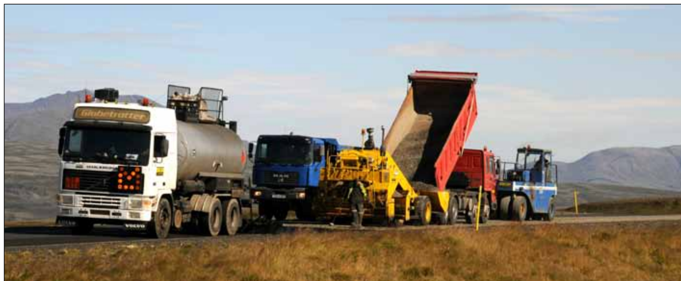
Verktaki leggur klæðingu á Þingvallavegi. Í opnu þessa blaðs er kort sem sýnir bundið slitlag á landinu og nýlagnir 2011.
