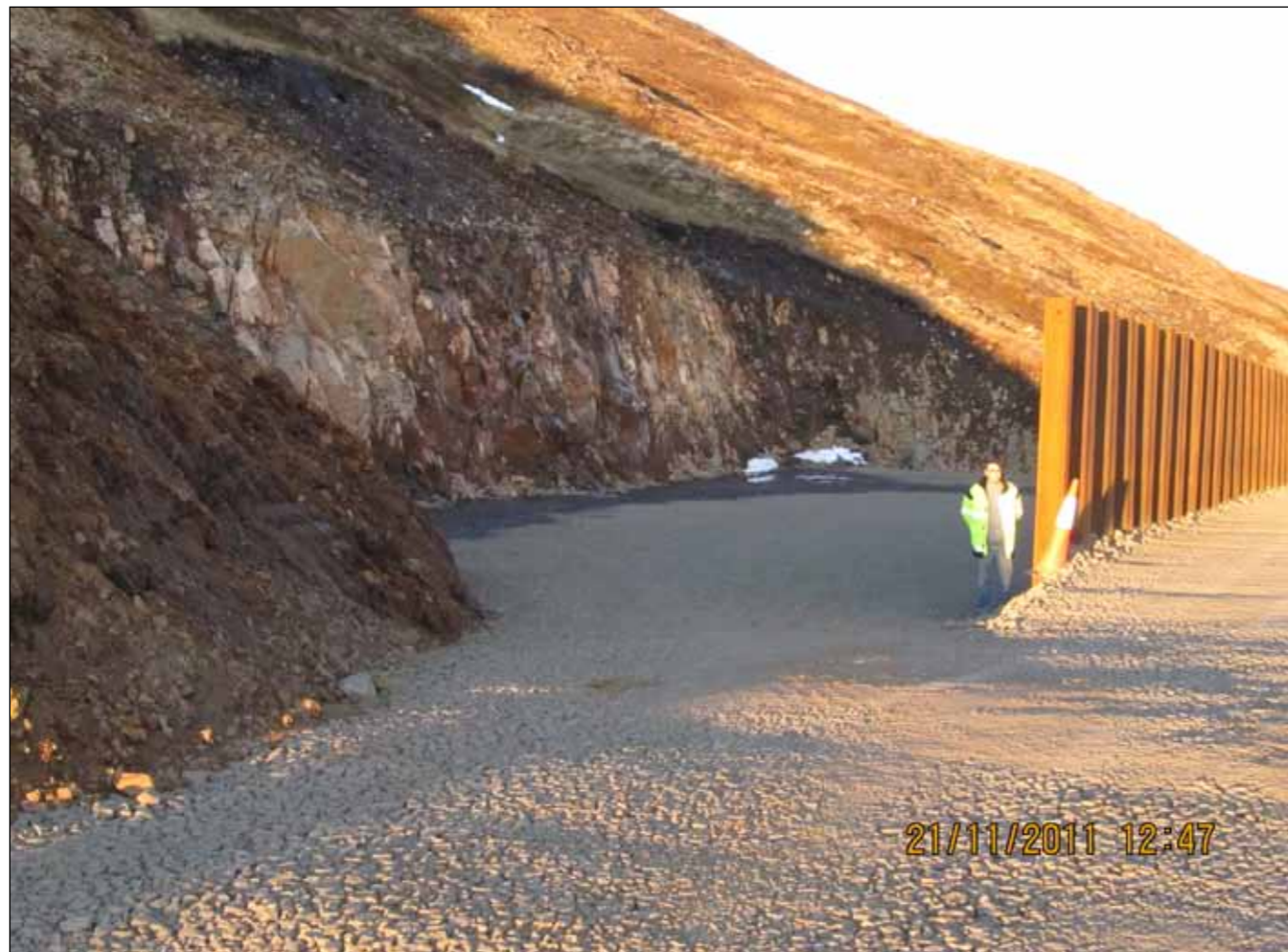
Á sl. ári var boðin út gerð snjóflóðavarna á Ólafsfjarðarvegi í Ólafsfjarðarmúla. Gerðir voru þrjár snjóflóðaskápar ofan vegar og stálþil sett upp fyrir framan þá, tvö 40 m og eitt 50 m. Efnid sem féll til við gerð skápanna var notað til breikkunar vegar og jöfnunar vegfláa á um 0,9 km kafla. Verktaki var Árni Helgason ehf. Á neðri myndinni má sjá skápana þrjá og hvernig snjóflóð hefur fyllt fremsta skápinn.
